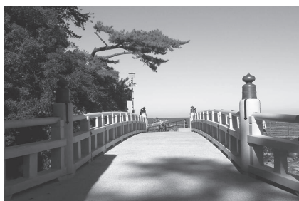
完成した禊橋
